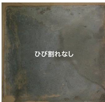
ひび割れなし
