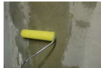
ローラーによる施工
