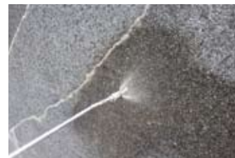
低圧スプレーによる施工
