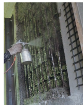
U-LN40溶液塗布状況
