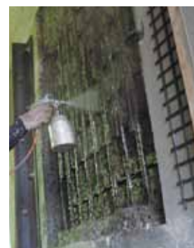
U-LN40塗布状況
